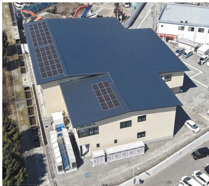
JAあづみ本所・豊科支所に設置した太陽光パネル
