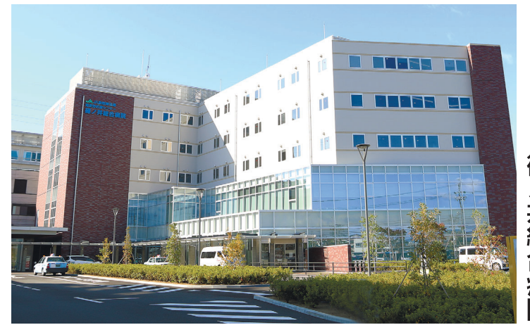
2期工事で完成した北病棟。病棟は全て個室化した
