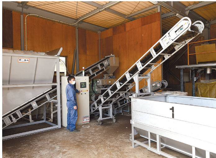
堆肥を製造する「土づくりセンター」内に設置したペレットマシン
